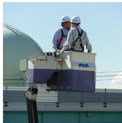
高所作業車体験乗車(バケット車)
